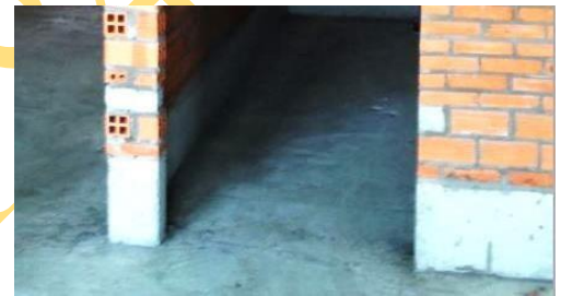
Chân tường wc đổ gờ bê tông (hoặc xây 5 hàng gạch định)
