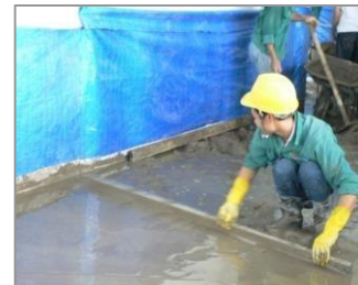
Cán nền bảo vệ lớp chống thấm
