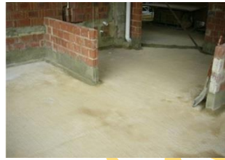
Quét chống thấm lớp 1 (góc xi măng)
