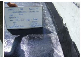
Gia cố góc tường
