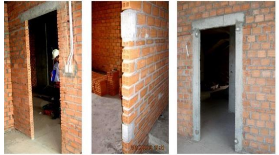
Cạnh cửa xây gạch đỉnh Cạnh cửa kê bê tông Cạnh cửa đổ bổ trụ bê tông
